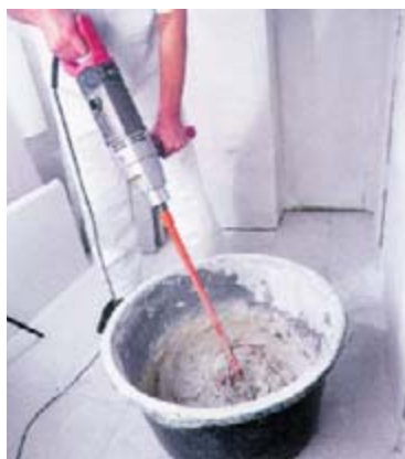
Приготовление монтажного клея
