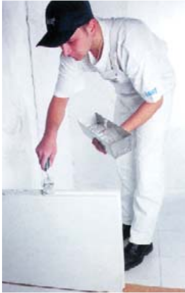
Нанесение монтажного клея
