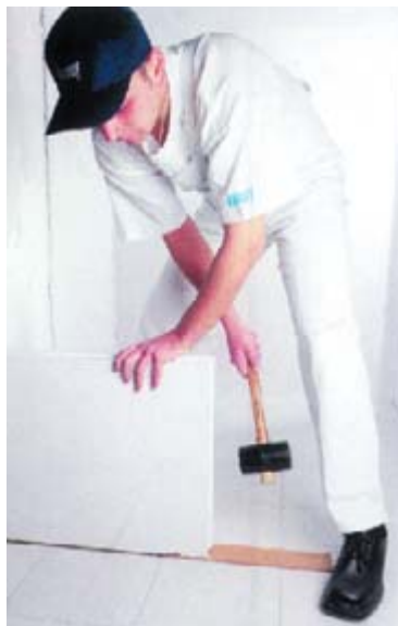
Установка первого ряда плит
