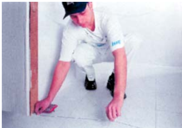
Разметка проектного положения перегородки на полу с помощью красящего шнура
