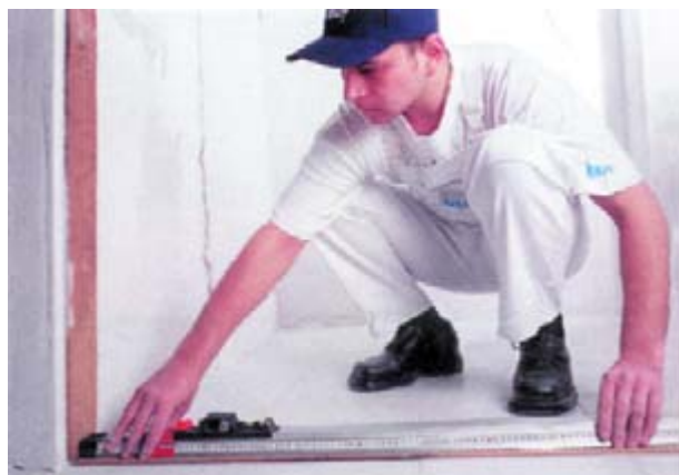
Проверка горизонтальности основания
