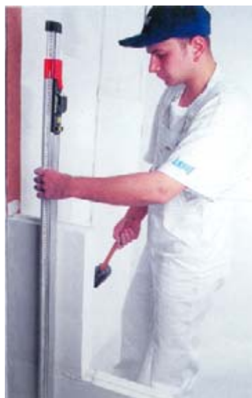
Проверка вертикальности кладки
