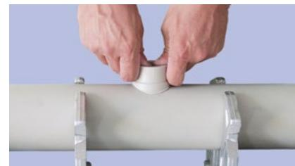
④ Нагріте сідільце встановіть в нагрітий отвір і зафіксуйте приблизно на 16 секунд. Через одну годину систему можна заповнити водою і піддавати дії тиску.
