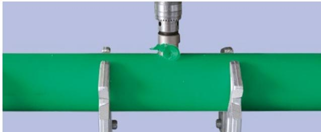
① За допомогою спеціального свердла просвердліть отвір для сідельця.
