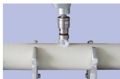
① Спеціальною фрезою висвердліть отвір для сідільця.
